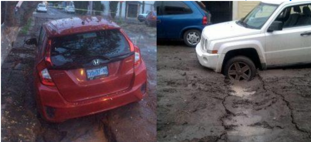
Se hunde calle donde realizaban obras en la colonia San Isidro II, en León; dos vehículos quedan atrapados
